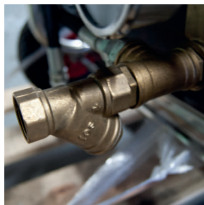
• Filtro de agua, elimina las impurezas del agua que podrían producir daños en la bomba.
