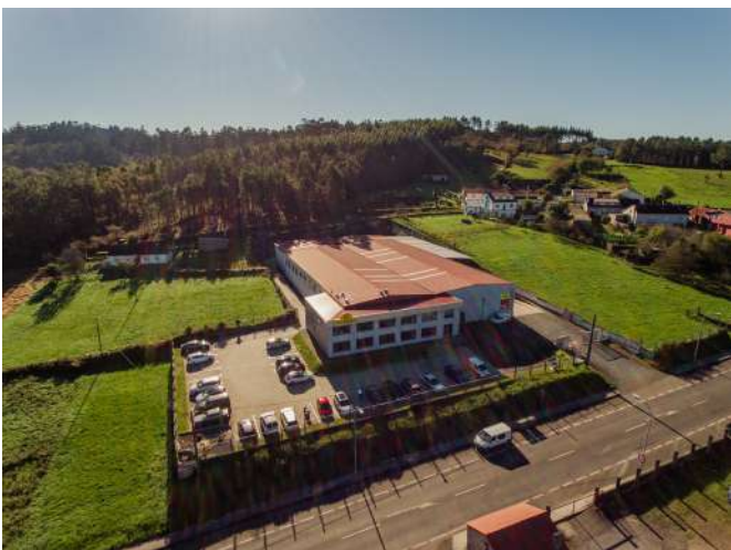
Oficinas y almacén ( Matalobos-A Estrada).
