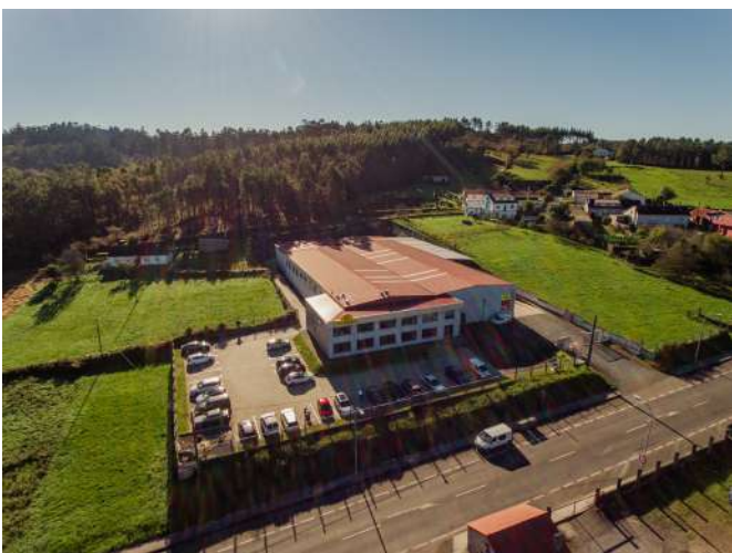
Oficinas y almacén ( Matalobos-A Estrada).
